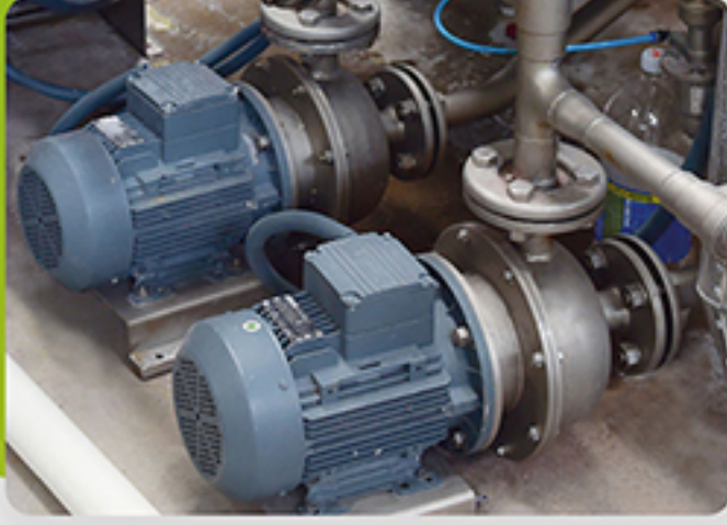
DOZAJLAMA POMPASI DOSING PUMP
